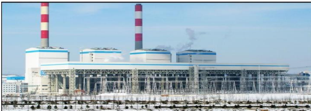
陕西国华锦界（4×600MW）煤电一体化项目
