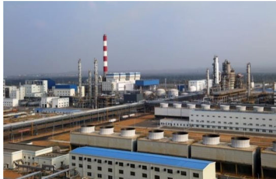
煤化工企业 Coal-Chemical Plants
